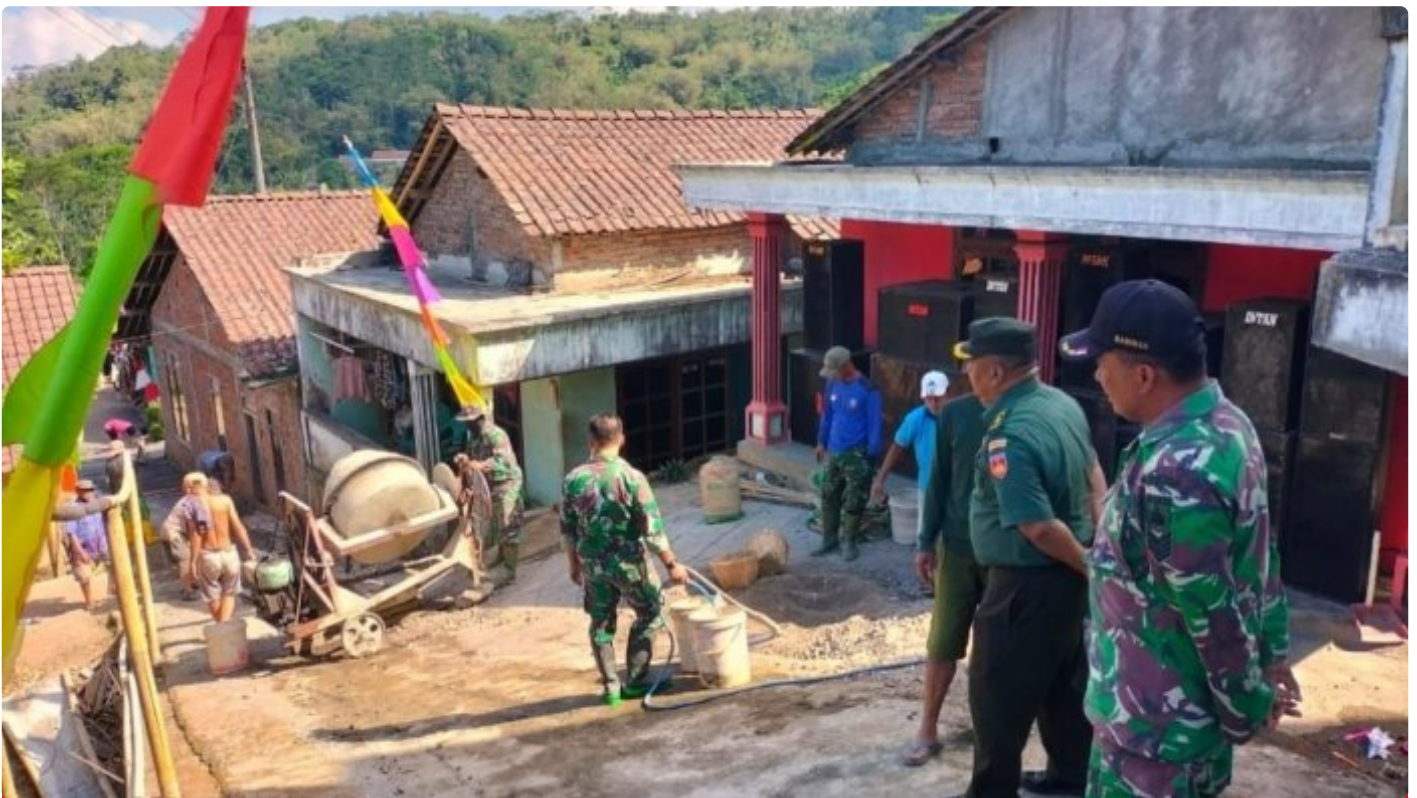
Kasdim Magelang Cek pengerjaan sasaran fisik TMMD sengkuyung di Kecamatan Bandongan
